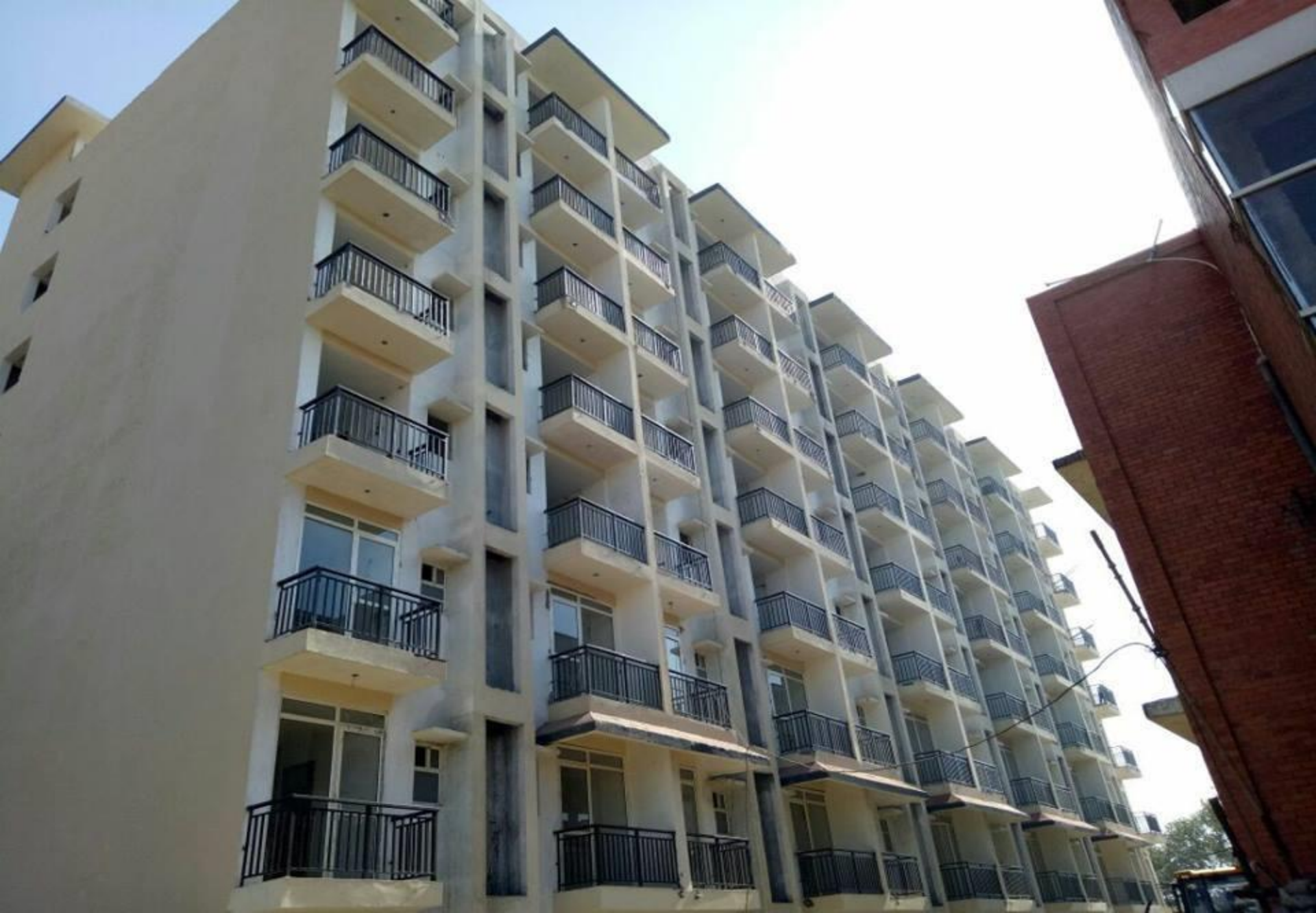
Actual Construction Pics
