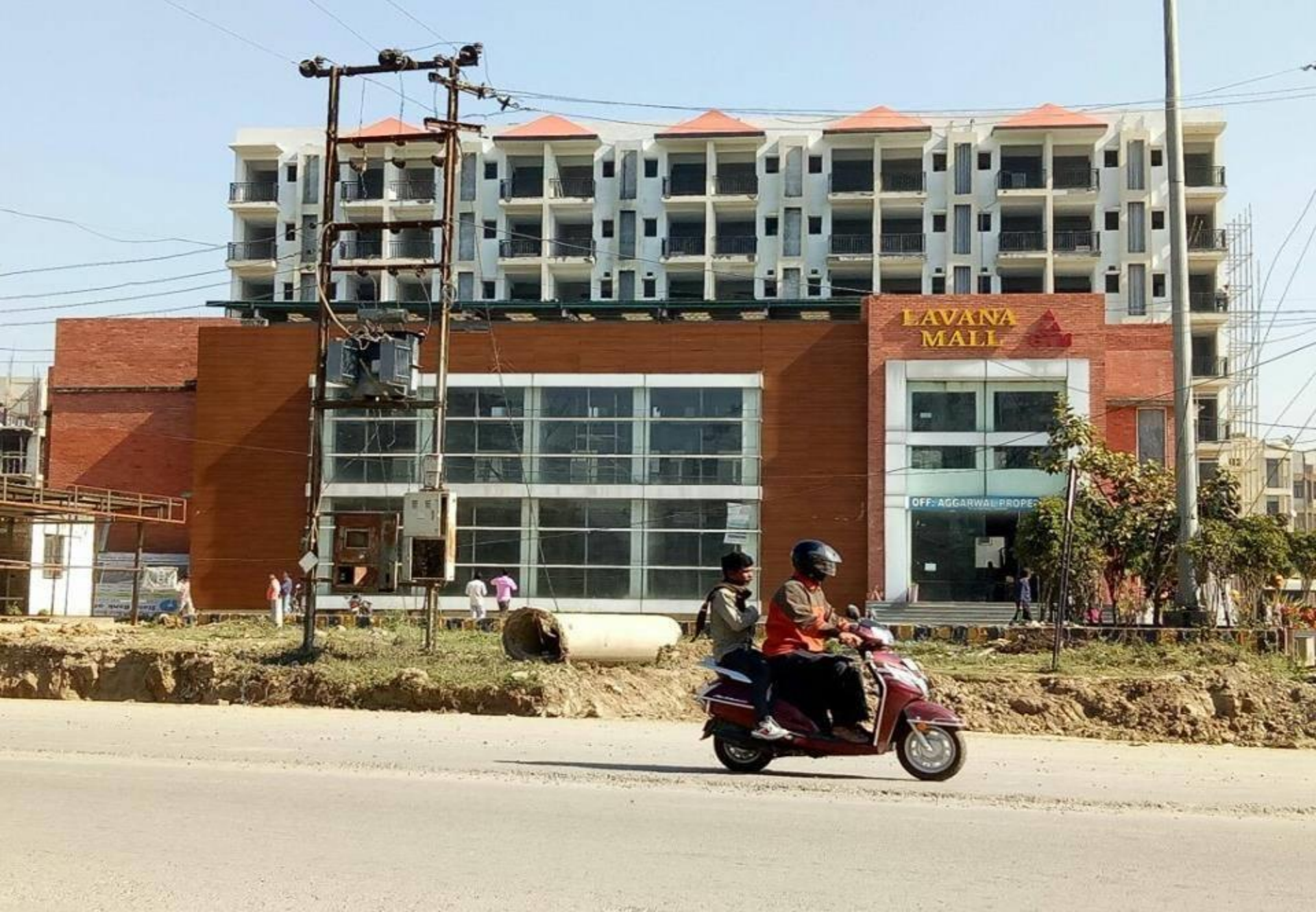
Actual Construction Pics
